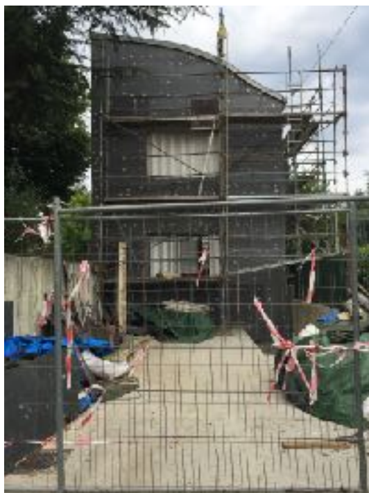
Toiture galbée en zinc sur la rue Durand Benech
