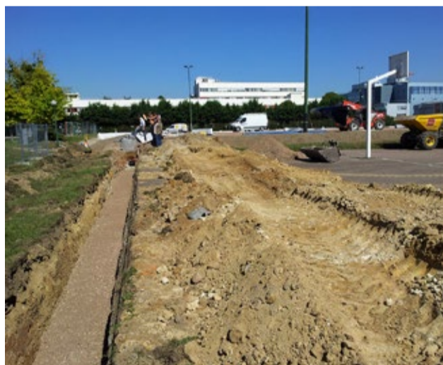
Pose d'un regard d'eaux pluviales destiné à évacuer l'eau de pluie de l'ensemble des drains. Il permet entre autres de vérifier la bonne évacuation des eaux.
