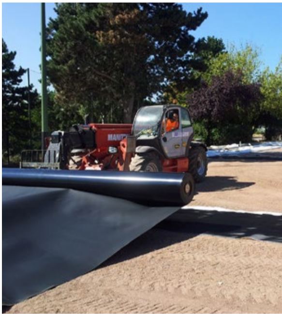
Mise en place de la géomembrane de drainage des eaux
