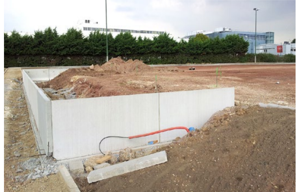
Installation d'un mur de soutènement qui permet de contenir de la terre sur une surface réduite.
