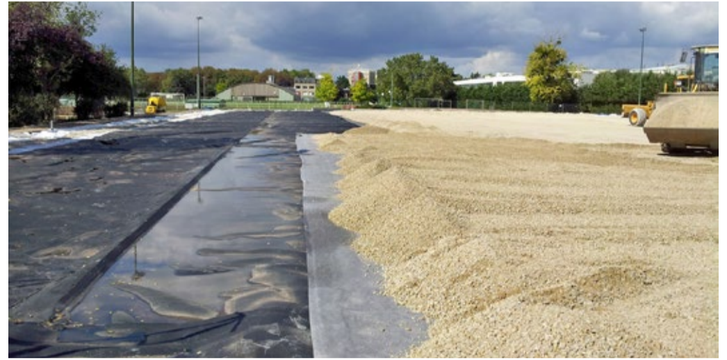
A gauche : géomembrane et à droite : mise en place de grave drainante
