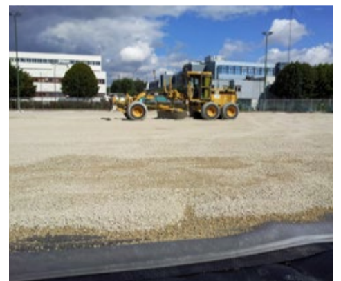
A gauche : géomembrane et à droite : mise en place de grave drainante
