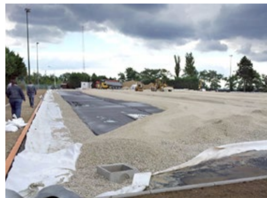
Mise en place de la grave drainante sur l'ensemble du terrain
