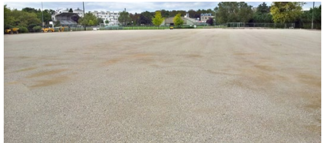
Plateforme constituée de la grave drainante sur l'ensemble. La planéité et la perméabilité seront vérifiées par un bureau de contrôle
