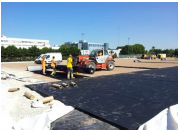
Géomembrane posée et soudée à chaud
