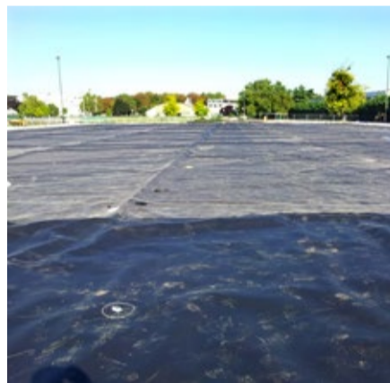
Plateforme constituée de la grave drainante sur l'ensemble. La planéité et la perméabilité seront vérifiées par un bureau de contrôle
