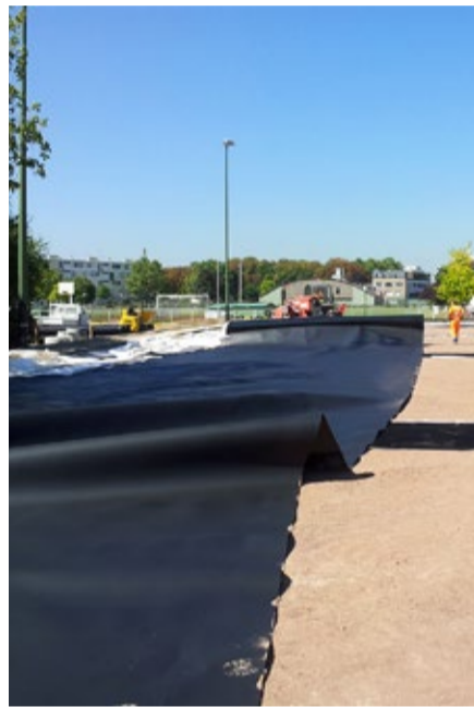
A gauche : géomembrane et à droite : mise en place de grave drainante
