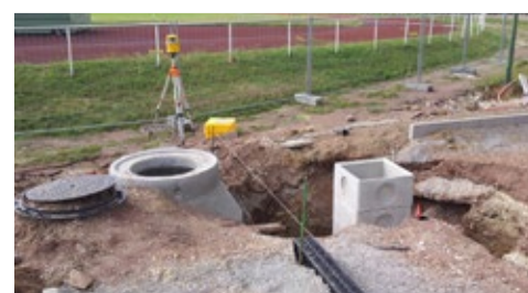
Pose d'un regard d'eaux pluviales destiné à évacuer l'eau de pluie de l'ensemble des drains. Il permet entre autres de vérifier la bonne évacuation des eaux.
