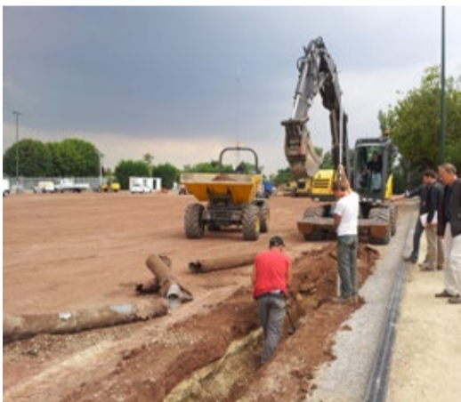
Réalisation du terrassement en déblais et remblais qui fera office de fond de forme.
